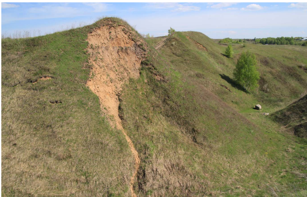
Рис. 2.8. Оборонительные валы Старорязанского городища разрушаются под действием оползневых и эрозионных процессов (фото А. В. Водорезова)
