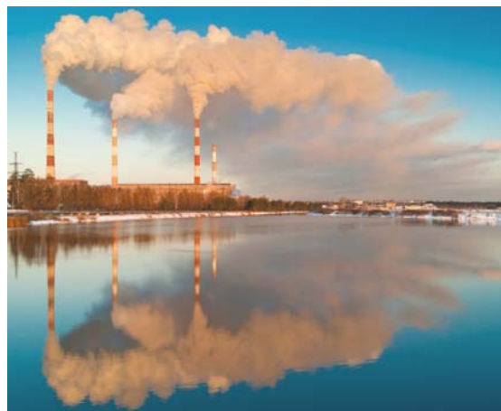
Рис. 3.12. Надымляющие струи техногенных выбросов при ночной радиационной инверсии выхолаживания 4 (слева) и антициклональной инверсии оседания 5 (справа)
